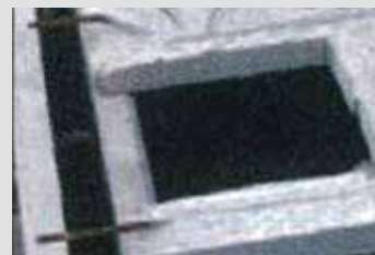
Mindestauflagertiefe 5 cm: Bei Unterschreitung Randunterstellung erforderlich
