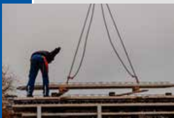
Bild 5: Winkel zwischen Gehänge und Deckenelement \geq 60^\circ
