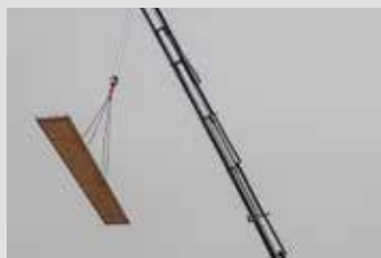
Bild 6: Kranhaken in Knotenpunkten der Gitterträger einhängen
