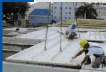
Bild 7: Verlegung der Deckenelemente
