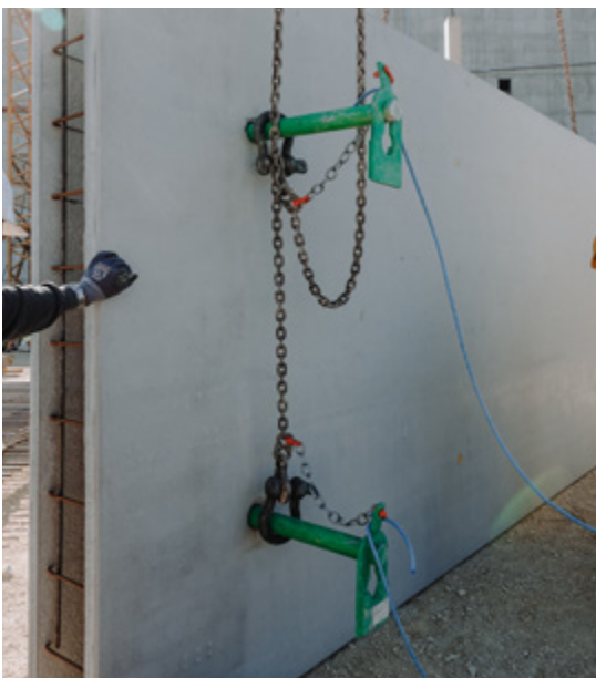
Bild 8. Abrutschsicherung (Frosch) anbringen
