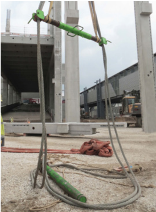
Bild 6. Montagewelle und Seilspreize an Tragseile anbringen
