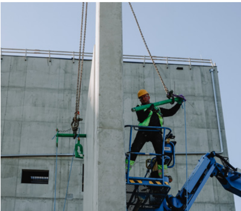
Bild 13. Ausfahren der Montagewelle
