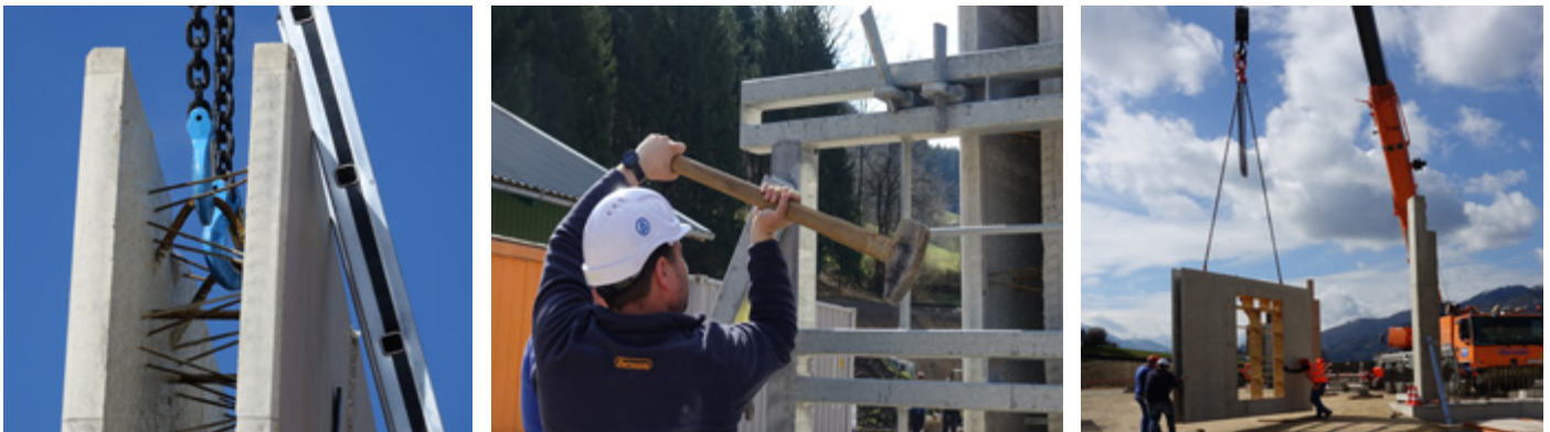
Bild 1: Kran muss senkrecht heben, nicht drücken
