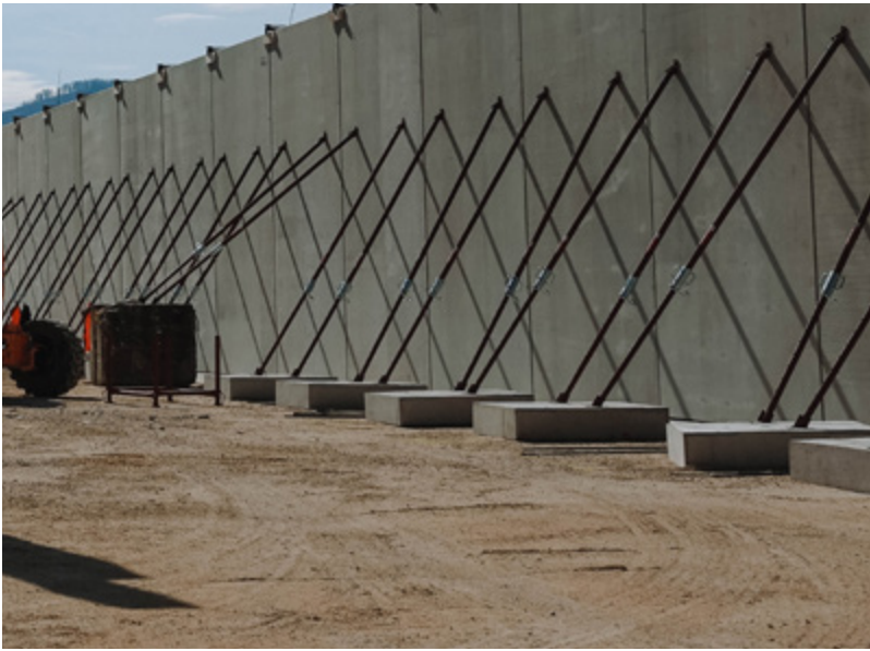
Bild 11. Ausrichten, Montieren und Sichern der Betonfertigteile
