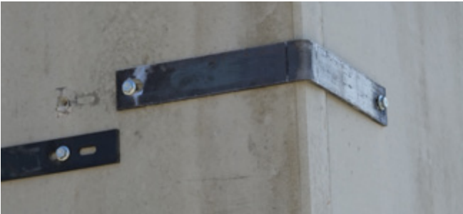
Bild 7: Stahlwinkel zur Sicherung gegen Aufweiten der Ecke
