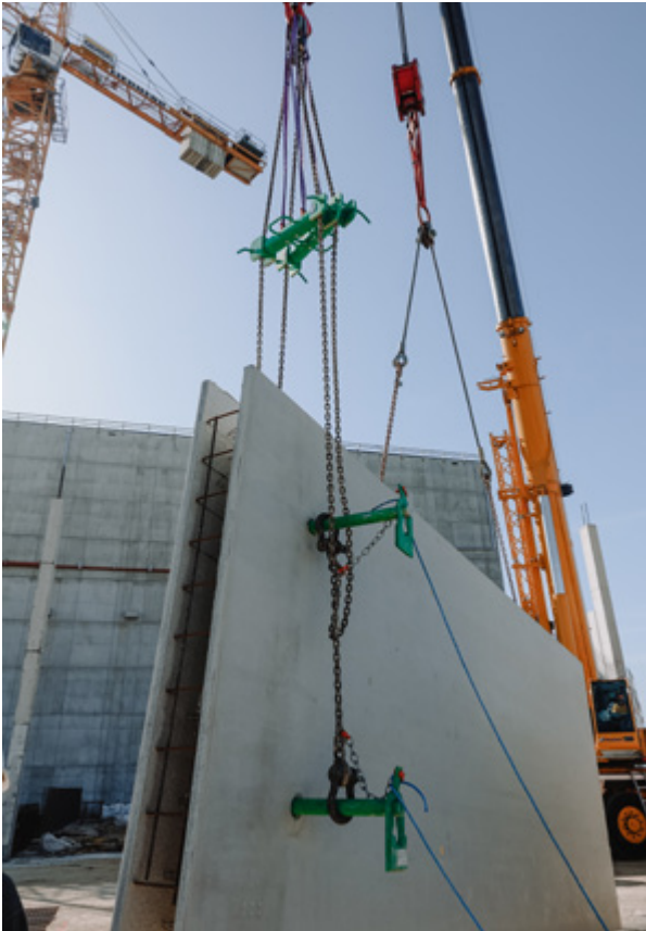
Bild 9. Heben des Betonfertigteils
