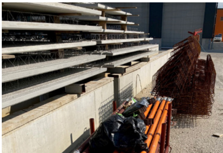
Bauseitige Vorbereitung der zu retournierenden Schrägstützen und Montagematerialien.
