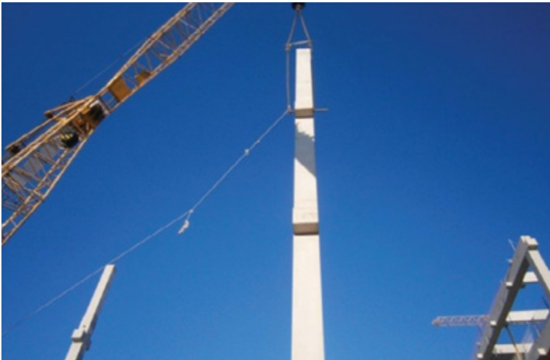
Bild 12. Fernauslösen der Abrutschsicherung (Frosch)
