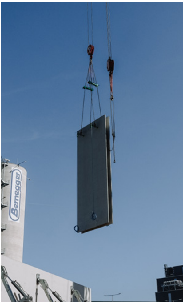
Bild 10. Verfahren des Betonfertigteils
