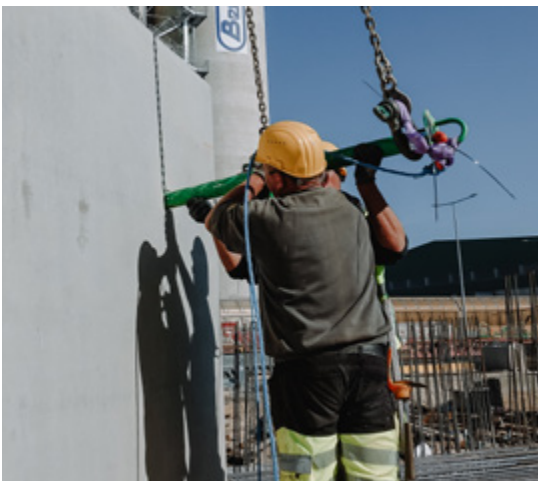
Bild 7. Montagewelle einführen
