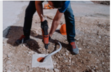
8. Bohrungen für die Montageplatte setzen
