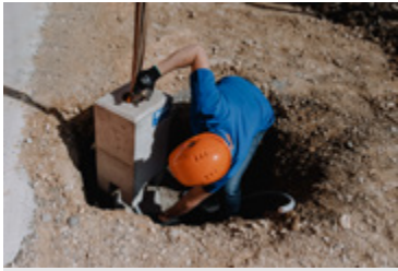
5. Versetzung des Fundaments und Einziehen des Kabels
