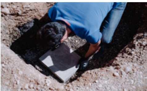
3. Basis-Betonplatte waagrecht ins Niveau einrichten
