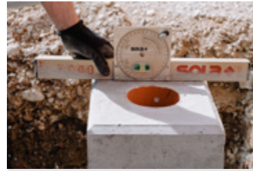
6. Waagrechte Ausrichtung kontrollieren
