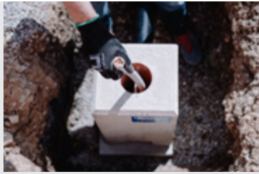
5. Versetzung des Fundaments und Einziehen des Kabels
