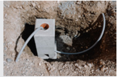
6. Waagrechte Ausrichtung kontrollieren
