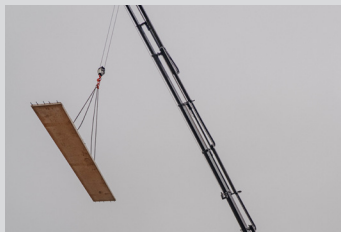
Bild 6: Kranhaken in Knotenpunkten der Gitterträger einhängen
