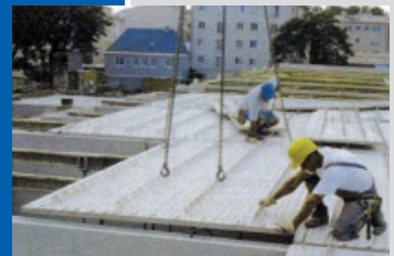
Bild 7: Verlegung der Deckenelemente
