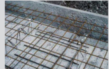
Bild 9: Obere Bewehrung und Fugenstoßbewehrung
