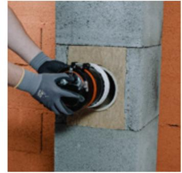
Putztüre (N) mit Nägeln am Mantelstein befestigen und Revisionsverschluss (M) einsetzen.
