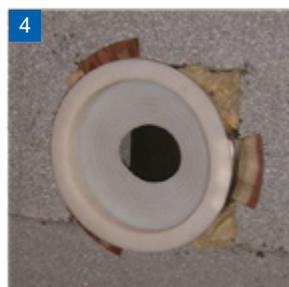
4 Adapterdichtung in die Anschlussgarnitur einsetzen.
