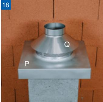
Mündungskonus\* auf Kamin Abdeckung setzen und mittels Klemmband befestigen. Bei Abdeckplatten anderer Art, zB Verblechung, ist darauf zu achten, dass der Hinterlüftungsringspalt von 4 cm frei bleibt.
