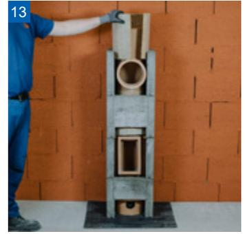
Dämmmatten einlegen und entlang der Hinterlüftungskanäle ausschneiden. Unterseite Rauchrohranschluss Fugenmasse aufbringen und versetzen.
