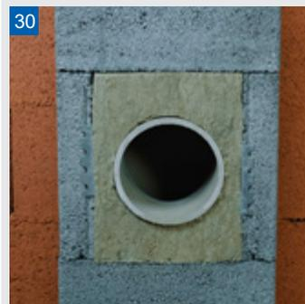
Abdichten des Rauchrohres mittels keramischer Dichtschnur.
