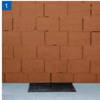
**1** Kaminfundament in Beton oder Mauerwerk bis Oberkante fertigen Fußboden herstellen. Feuchtigkeitsisolierung aufbringen.
