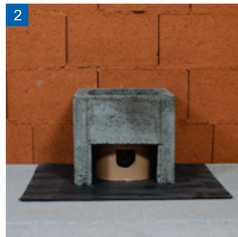
**2** Öffnung für Lüftungsgitter: Mantelstein entlang der Einkerbungen auf halbe Höhe ausschneiden. Konsolylinder\* einsetzen.
