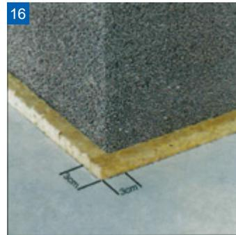
Abstände bei Decken- oder Dachdurchführungen mit nichtbrennbarem Material ausfüllen. Abstände: zu Beton mind. 3 cm zu Holz mind. 5 cm
