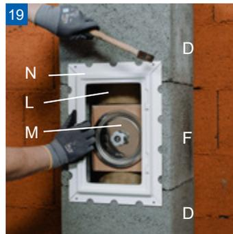
Nach Abschluss der Versetzarbeiten Putztüre und Revisionsverschluss montieren und Kamin verputzen.
