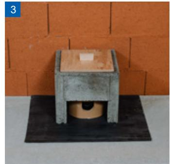
**3** Mörtelschablone\* auflegen. Mörtel auftragen. Mörtelgruppe M5 (5 N/mm oder größer) Hinterlüftungskanäle müssen immer frei bleiben.
