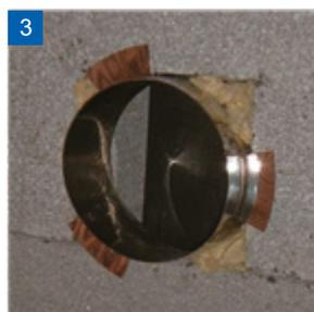
3 Anschlussgarnitur in die Öffnung einsetzen und die offenen Ecken mit der Isolierwolle ausstopfen.
