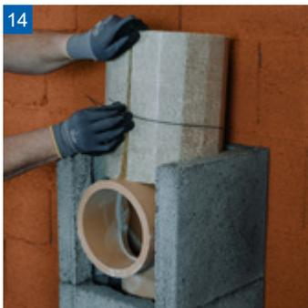
Isolierung mit Draht festbinden. Im Stoßbereich innen ausquellende Fugenmasse dicht und glatt verstreichen.
