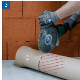
Bei Bedarf sind Muffenrohre (J) mit einer Trennscheibe zu kürzen. ACHTUNG beim Umgang mit der Trennscheibe.
