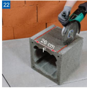
Der Mantelstein (F) für Putztüranschluss ist mit einer Trennscheibe zu schneiden.
