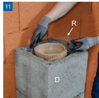
Distanzfeder\* zur Fixierung des Muffenrohres in Ringspalt einlegen.
