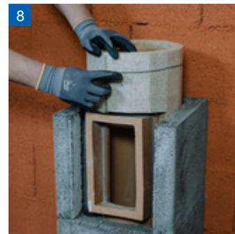
**8** Isolierung mit Draht festbinden und Mörtel auf Mantelstein auftragen.
