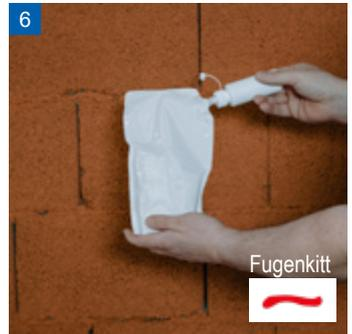
Fugenkitt\* vorbereiten. ACHTUNG: Der Fugenkitt ist genau nach Anleitung zu verarbeiten!
