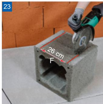
Der Mantelstein (F) für Putztüranschluss bzw. Lüftungsgitter (W) ist mit einer Trennscheibe zu schneiden.
