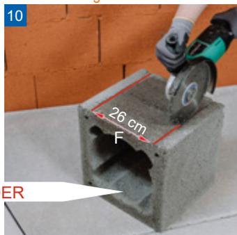
Bei RA- oder Putztüranschluss sind die Mantelsteine mit einer Trennscheibe zu schneiden.
