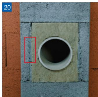
Haltewinkel seitlich in die 2 Frontplatten\* aufstecken und Öffnung verschließen. Mit Putzbewehrung armieren. Zwischen Putz und Rauchrohranschluss Trennfuge ausbilden.
