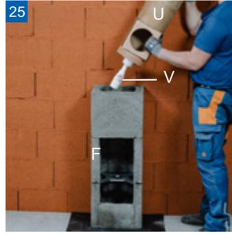
Auf Fußteil-Formstück (U) Kondensatablauf (V) und Distanzfeder (R) montieren und auf Zwischenplatte (T) aufsetzen. Öffnung ausrichten.
