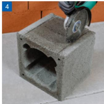
**4** Putztüranschluss herstellen. Öffnung ausschneiden. Schnittführung entlang der Einkerbung. Mantelstein versetzen. Sicherheitshinweise beachten!
