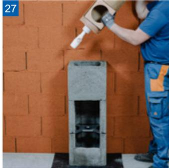
Auf Fußsteil\_Formstück (U) Kondensatablauf (V) montieren und auf Zwischenplatte (T) aufsetzen. Öffnung ausrichten.
