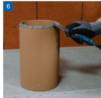
**6** Rohrenden säubern und leicht anfeuchten. Fugenmasse entsprechend der Anleitung (auf dem Eimer) anmachen. Auf Unerseite Putztüranschluss max. 7 mm auftragen. Ausquellende Fugenmasse nach jedem Versetzen eines Schamotterohres verstreichen.
