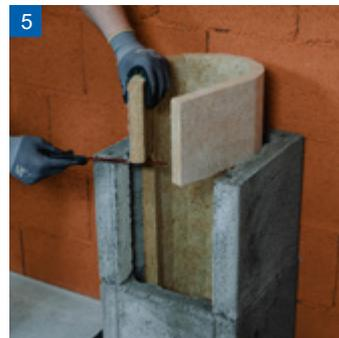
**5** Dämmplatte biegen und mit Außenseite schwarzer Vlieskaschierung einsetzen. Plattenstöße dürfen nicht im Bereich der Hinterlüftungskanäle liegen. Entlang der Hinterlüftungskanäle ausschneiden. (Säge im Grundpaket) Dämmplatten vor Feuchtigkeit schützen.
