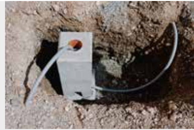
6. Waagrechte Ausrichtung kontrollieren
