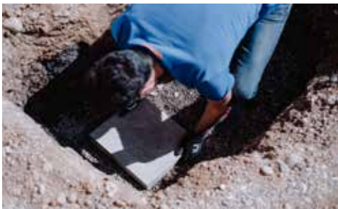
3. Basis-Betonplatte waagrecht ins Niveau einrichten
