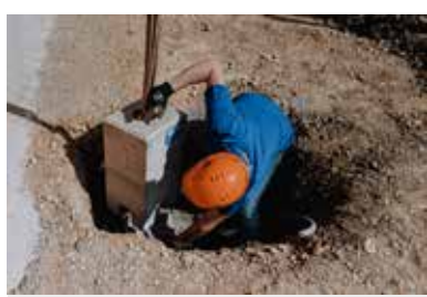
5. Versetzung des Fundaments und Einziehen des Kabels
