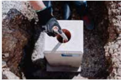
5. Versetzung des Fundaments und Einziehen des Kabels
