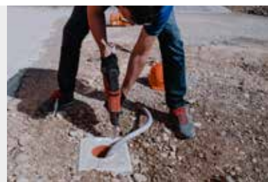
8. Bohrungen für die Montageplatte setzen
