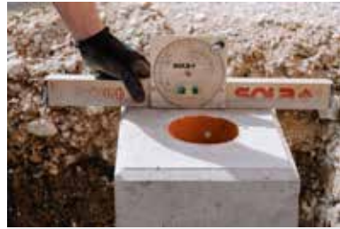
6. Waagrechte Ausrichtung kontrollieren
